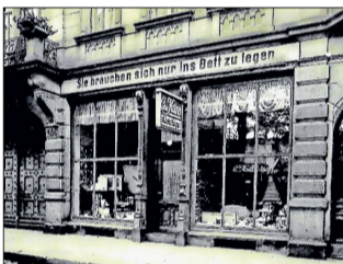
Das Geschäft vor rund 100 Jahren. FOTO: BURK/GRATIS
